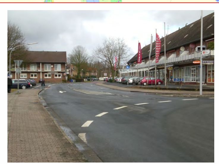
3 Umwandlung in Shared-Space-Bereich bei Sanierung "Nodiker Straße"
