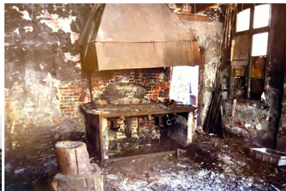
Werkstatt mit Feuerstelle – noch gut zu erkennen trotz der Schäden durch Vandalismus
