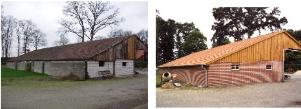
DE Groß Berßen, Landkreis Emsland Dachsanierung und Neuverklinkerung einer Wagenremise in der Ortmitte
