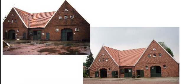
DE Liener, Auen-Holthaus, Landkreis Cloppenburg Dachsanierung und Fassadensanierung beim ortstypischen Wohngebäude
