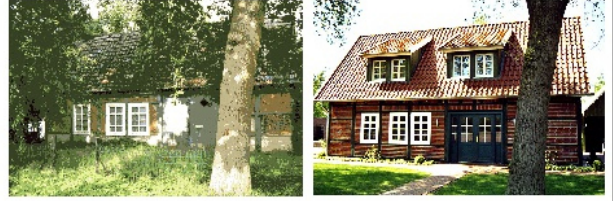
DE Liener, Auen-Holthaus, Landkreis Cloppenburg Sanierung und Umnutzung eines ehemaligen Landarbeiterhauses zum Ferienhaus
