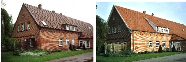
DE Liener, Auen-Holthaus, Landkreis Cloppenburg Dachsanierung und Fassadensanierung beim ortstypischen Wohngebäude
