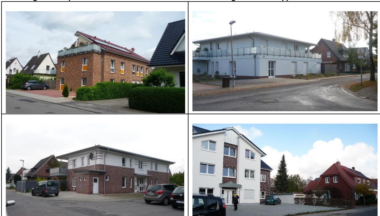
Abbildung 24: Beispiele von Ersatzbauten/Neubauten in Bestandsgebieten in Meppen
