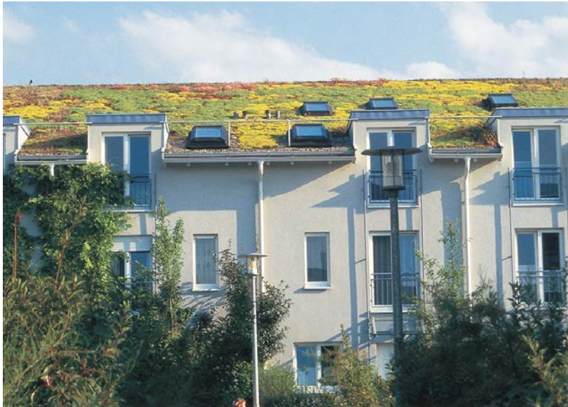
Schräg- oder Satteldach mit extensiver Dachbegrünung
