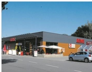
Im Rewe-Markt in Meppen ist es am Donnerstagabend zu einer brenzligen Situation gekommen. Ein Lüftungsrohr an der Decke hatte sich gelöst und stürzte auf den Boden. Foto: Harry de Winter
